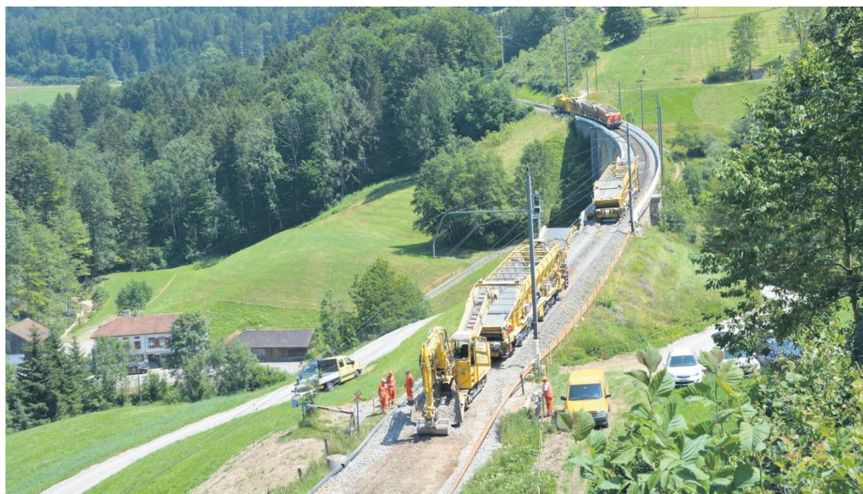
Die Vanoliner genannte Maschine weist eindruckliche Dimensionen auf. Vom Waldbachviadukt bis Degersheim ist das Gleis schon saniert.
